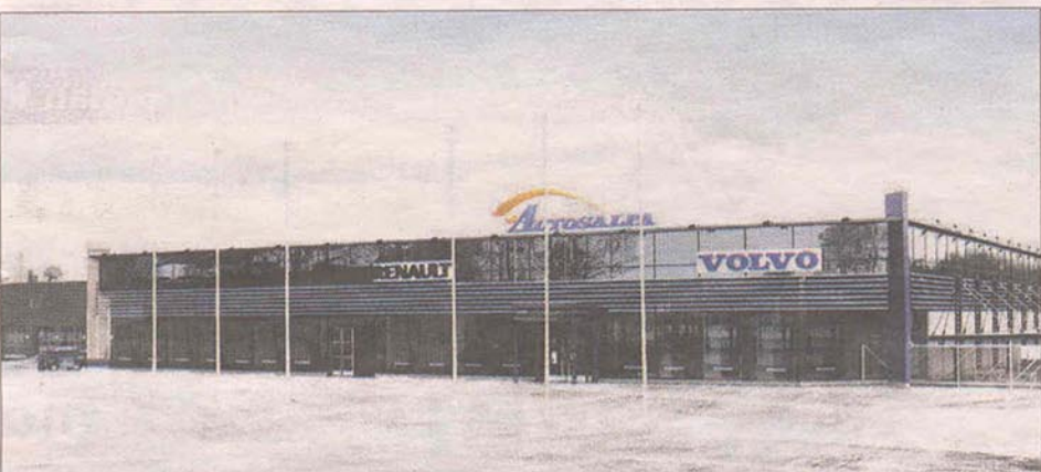
ULIAS. Autosalpa Oy:n uudesta Kuninkaanportin toimitalosta on tulossa saman näköinen kuin yhtiön joulukuussa avattu Keravan toimitalo.
